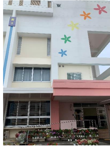
体育館・屋上プール
